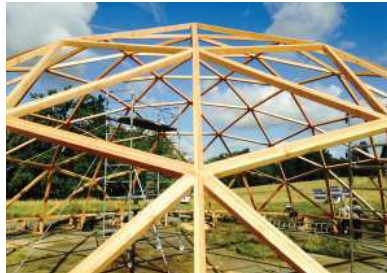
Dôme Géodésique Client. POC21 Location. Millemont, Paris Year. 2015 Team. DAT Pangea+Quatorze Architects
